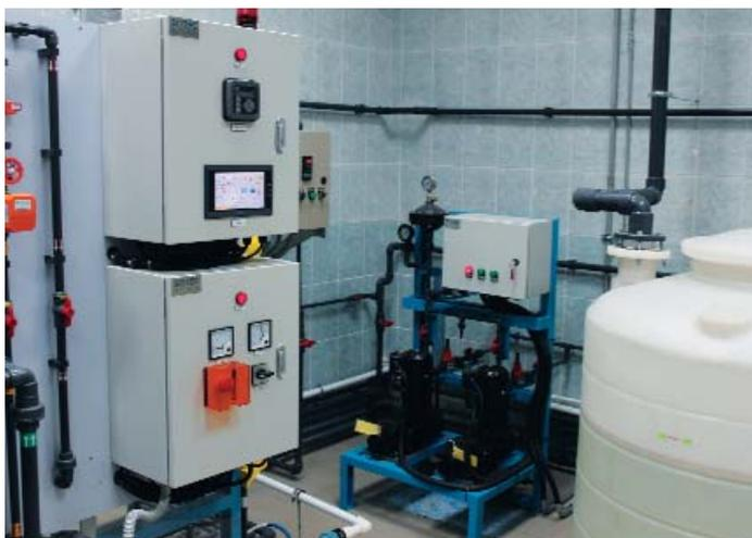
Установка по производству гипохлорита
